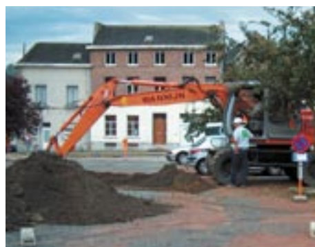
Onderaan de Vesten werd aan de parking en de straat een sleuf gegraven
